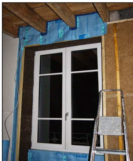
Travaux de rénovation
